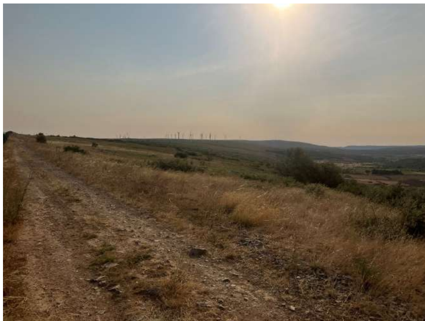
Le parc éolien de la Cazelle
