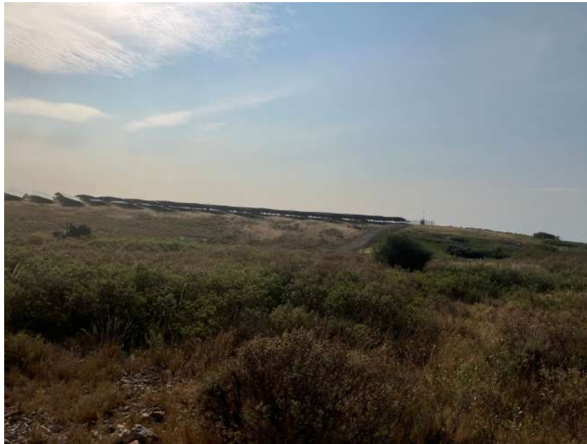
Vue de la centrale existante depuis la zone de projet
