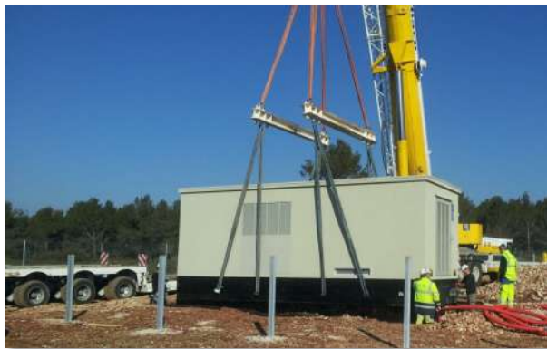
Installation des postes de transformation
