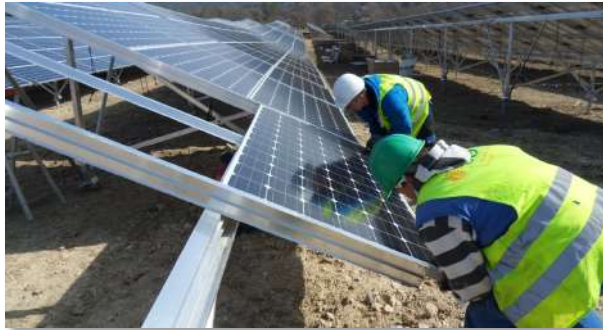
Montage des modules
