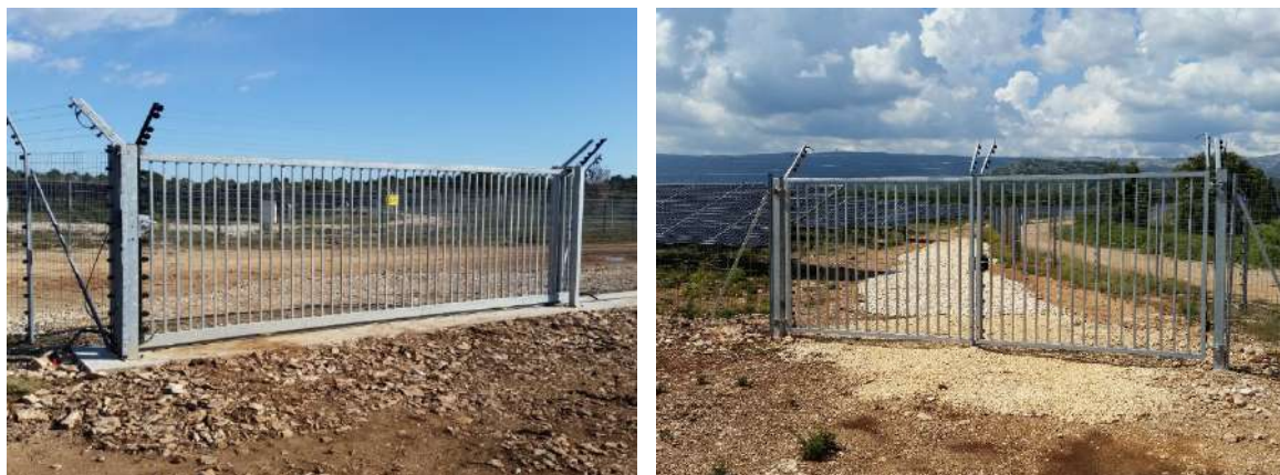
Figure 18 : Exemple de portail coulissant (à gauche) et de portail à battant (à droite) - Parc solaire de Castellet (83). Source : Voltaia.
