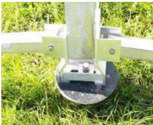
Figure 9 : Platine d'une vis d'ancrage
