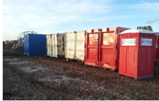
Bennes pour le stockage des déchets
