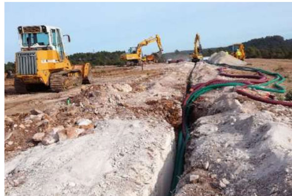
Réalisation des tranchées et installation des câbles
