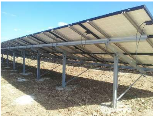
Raccordement électrique des modules
