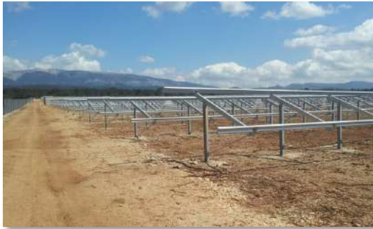
Montage des structures
