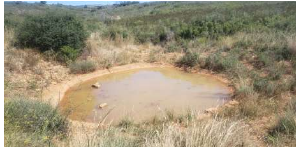
Mare artificielle (contours et fond en mortier) destinée à l'abreuvement des herbivores, au sud de l'AE immédiate.
