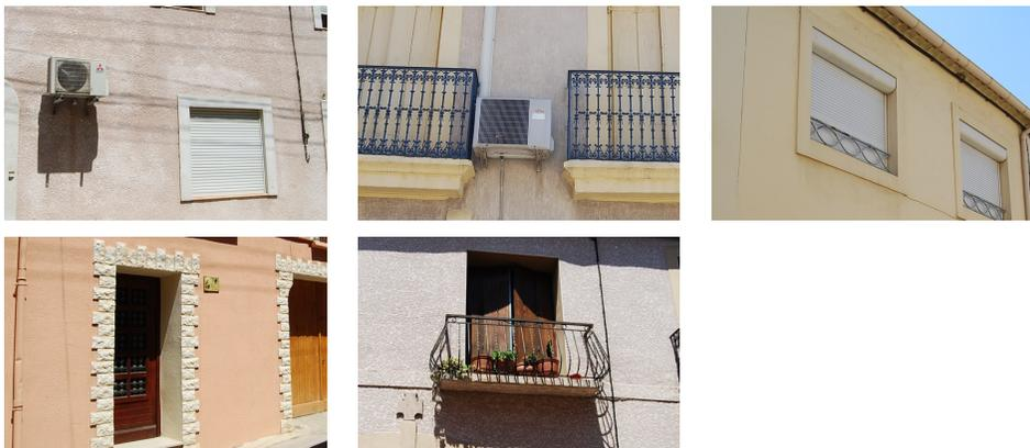
De nombreuses perturbations à éviter : climatiseur en façade, enduit écrasé, coffre de volet roulant apparent, fausse pierre, garde-corps à volutes, couleurs criardes, absence d'appui de fenêtre...
