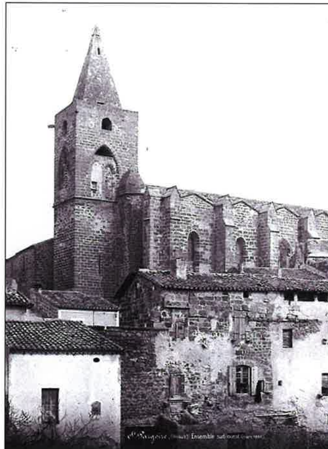
Photo 7 – L'église de Saint-Pargoire, état ancien de l'édifice et des bâtiments médiévaux environnants (cf. photo 5)
