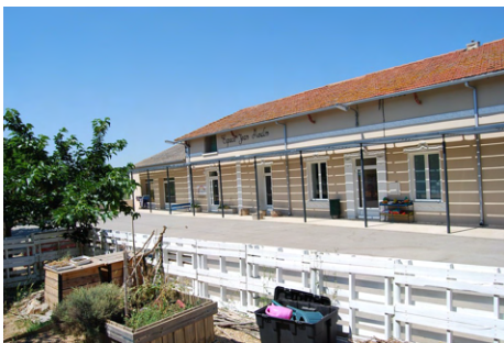
L'Espace Jean Moulin Source : crédit photo : Urban Projects
