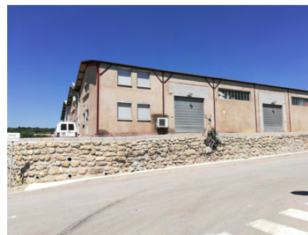
Un bâti vieillissant qui manque d'unité Source : crédit photo Urban Projects
