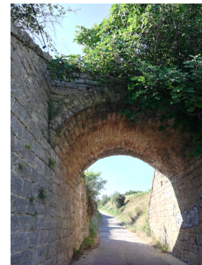
Ancien pont de la voie ferrée Source : crédit photo Urban Projects
