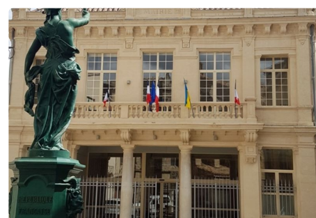
Rénovation de la Mairie
