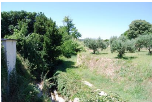
Réseau pluvial préexistant - Saint-Pargoire Source : Urban Projects
