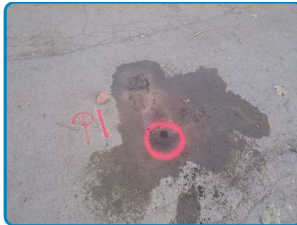
PRLV n° 1 sur P1 - Enrobé bitumineux
