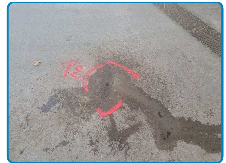
PRLV n° 2 sur P2 - Enrobé bitumineux
