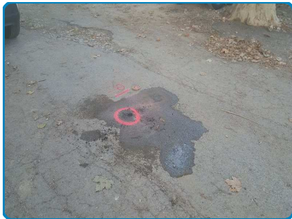
PRLV n° 1 sur P1 - Enrobé bitumineux
