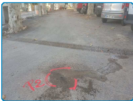
PRLV n° 2 sur P2 - Enrobé bitumineux
